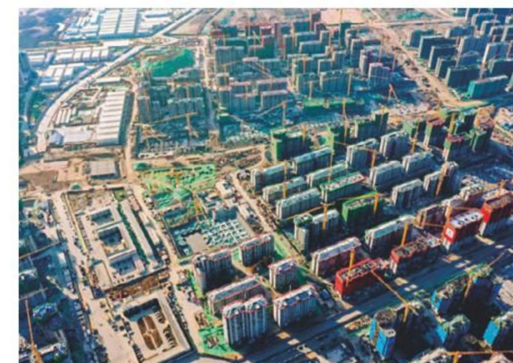
雄安新区容东安置房项目
