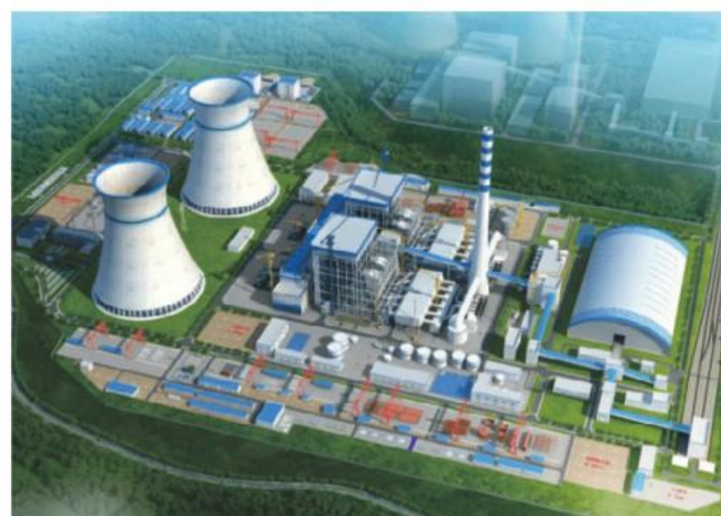
湖南华电平江一期2 × 1000MW煤电项目
