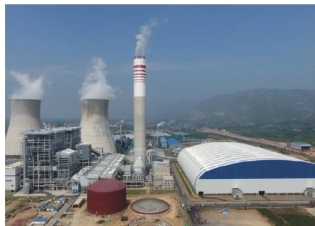
焦作丹河电厂2 × 1000mw机组工程
