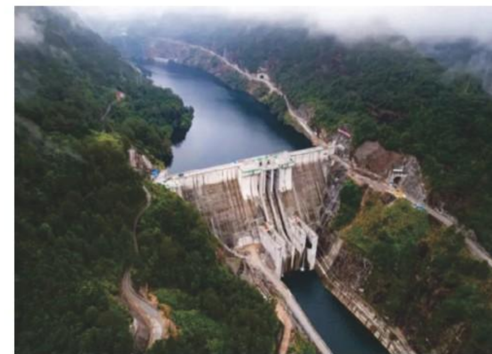
华电福新周宁抽水蓄能电站
